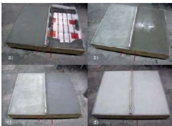
Obr. 4 Postup betonáže
