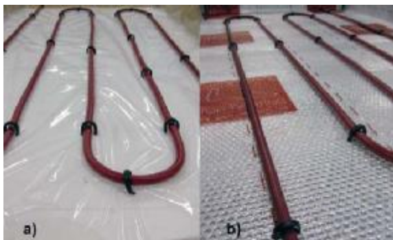
Obr. 3 Detail upevnění otopného hadu plastovými sponami vlevo – PE fólie; vpravo – termoreflexní fólie
